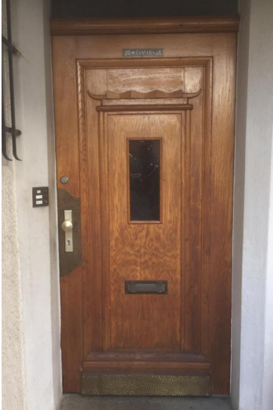
M28 Haustür Südwall 67 vor der Renovierung, Foto: Eva Kersting
