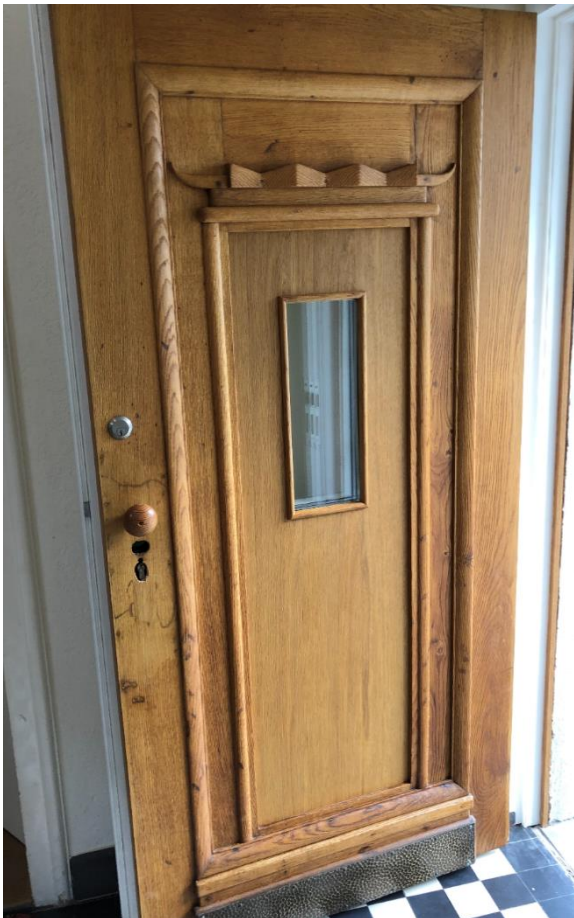
M30 Haustür Südwall 67 nach der Renovierung, deutlich erkennbare Beschädigungen der Reichskristallnacht, Foto: Eva Kersting
